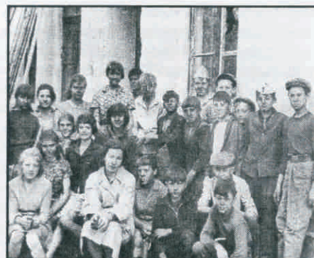
Ремонт восьмилетней школы № 25 г. Омска
